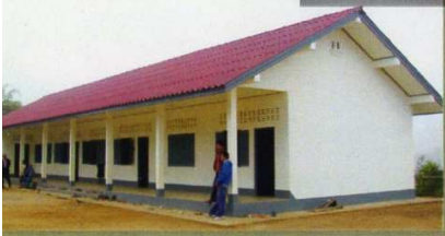
←完成した校舎
